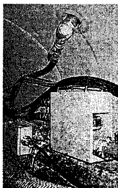
機動建設が開発した下水道工事向けの自動滑材注入システム
