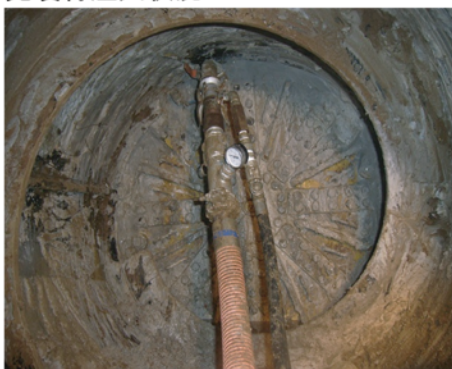
充填材注入状況
