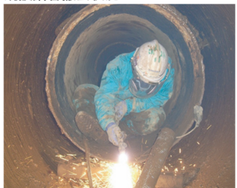
既設鋼管撤去状況
