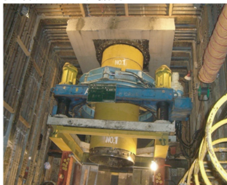
先頭ケーシング据付
