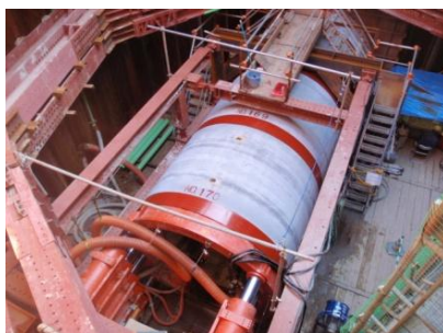
海底推進状況
