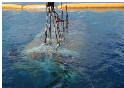
泥水式掘進機回収状況
