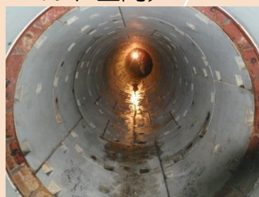
推進・シールド切替部
